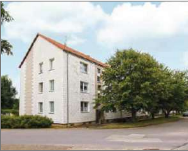
2 Mehrfamilienhäuser in Datzetal OT Salow
